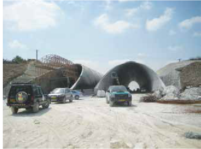
כביש 6, בניית המנהרות מתחת למעבר לפני כיסוי מחדש
