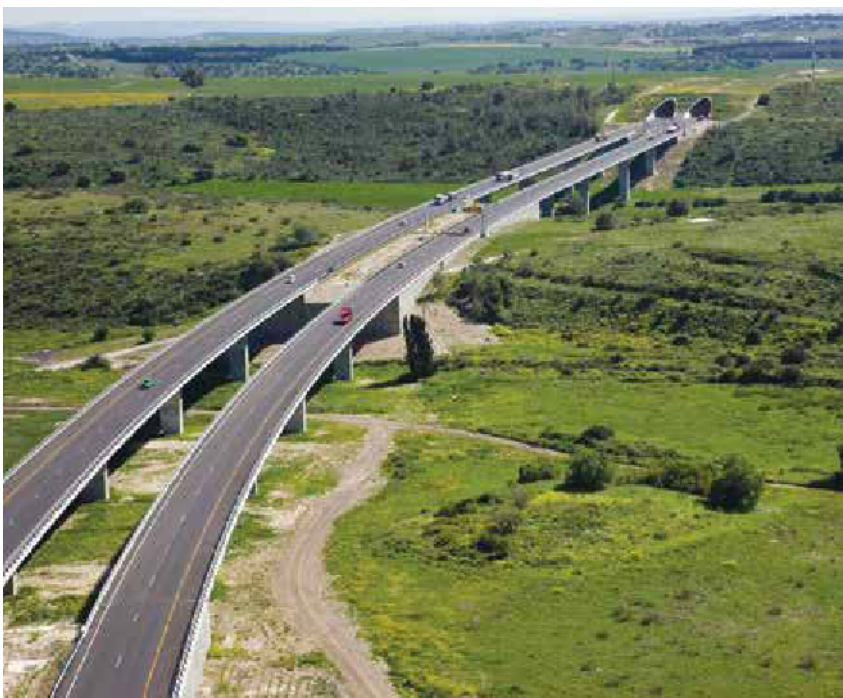
מעבר אקולוגי בכביש 6 קטע 18 - מעבר רצף שתוכנן בעיצוב אדריכלי כ"פיית חליל", בשיטת דימוי "מנהרה"
